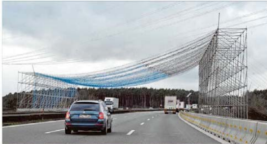
Ein Netz wurde über die A 6 bei der Anschlussstelle Ansbach geparkt. Es dient der Sicherheit während der Arbeiten zur Verbesserung der Kapazität der Stromleitung zwischen Winterschneidbach und Münchertbach. Das Foto entstand in Richtung Heilbronn. Foto: Jim Albrigt
