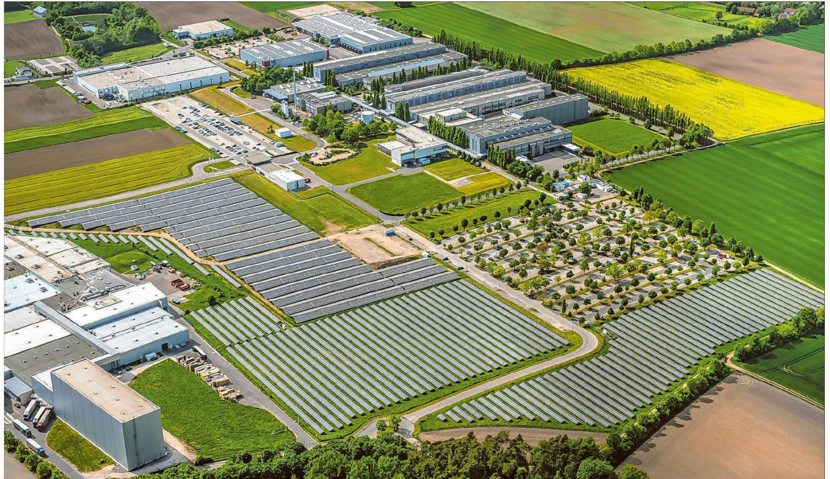
Auf dem Luftbild sind das ältere Solarfeld (rechts) und die seit September betriebene Photovoltaik-Anlage (links) zu sehen. Die Leistung aller Bosch-Solarflächen im Werk Ansbach beträgt im Peak (Spitzenleistung) 6750 Kilowatt. Foto: Robert Bosch GmbH
