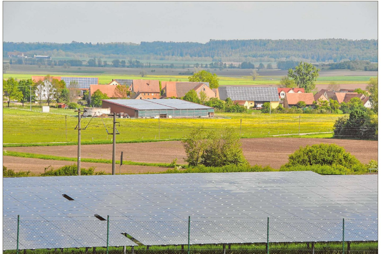
Strom aus Sonnenenergie wird bereits an vielen Stellen im Leutershäuser Stadtgebiet – hier bei Atzenhofen – erzeugt. Im Zeichen des Klimawandels soll Photovoltaik weiter ausgebaut werden – doch mit der Entwicklung von Richtlinien dafür tut sich der Stadtrat schwer. Foto: Wolfgang Grebenhof
